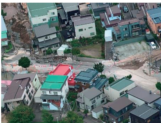
札幌市 液状化現象の被害状況① (札幌市消防局提供)
