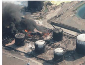
JX日鉱日石エネルギー(株)仙台製油所 (宮城県仙台市)
