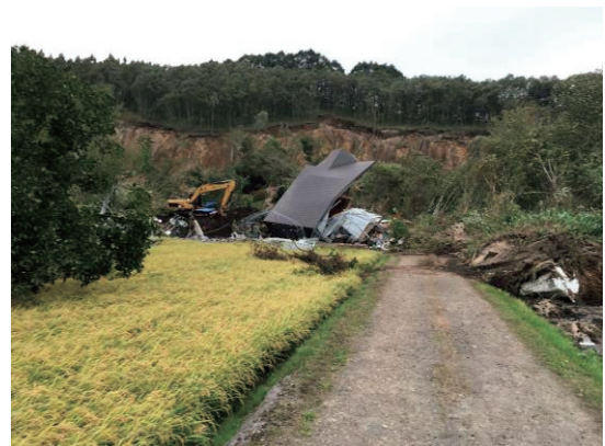
厚真町 土砂災害の被害状況② (仙台市消防局提供)
