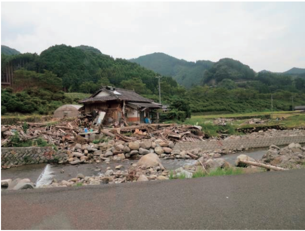
平成 29 年 7 月九州北部豪雨 被害状況
