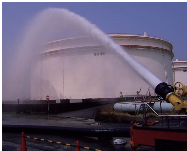
大容量泡放射システムによる放水訓練
