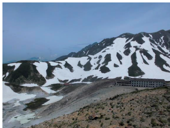
噴石対策を実施した民間施設 （富山県立山町 雷鳥荘）（立山町提供）
